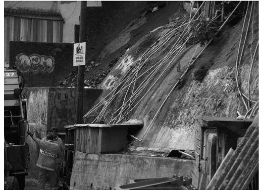
写真3：ファベラの水道。木のドアが付いた道沿いの箱の中にポンプがあり、これで水をくみ上げ、崖を無秩序に登るパイプで丘の上の家に配水している。
