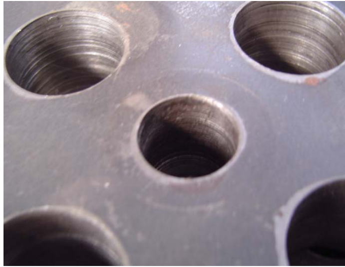
写真6 締結板のボルト締付痕の例
