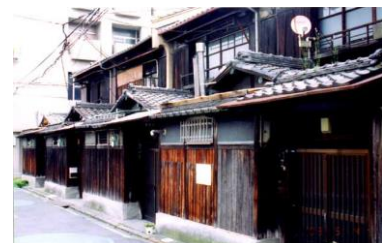
長屋全景（改修前）
