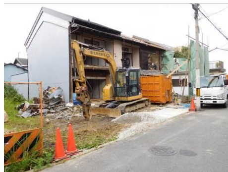
写真2 解体中の長屋に遭遇
