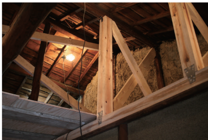
須栄広長屋2期 上：現場での打ち合わせ 下：小屋組の補強/上野 智博
