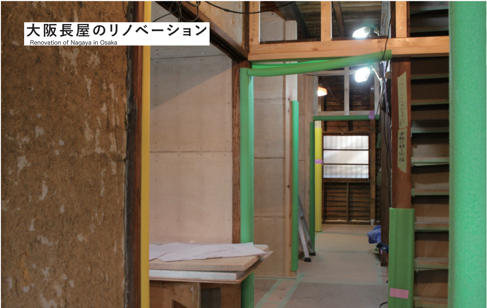
須栄広長屋2期：荒壁パネルの耐力壁を用いた耐震補強/上野 智博
