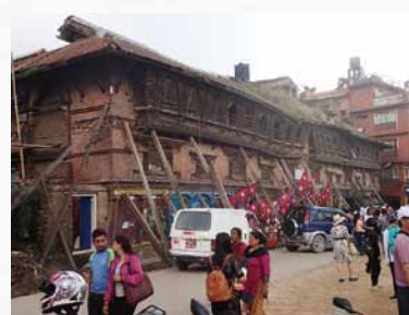
写真1 破損した古いネパール建物(Bhaktapuriにて)
