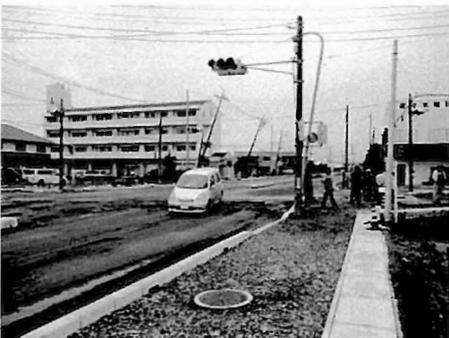
写真2 液状化による被害
