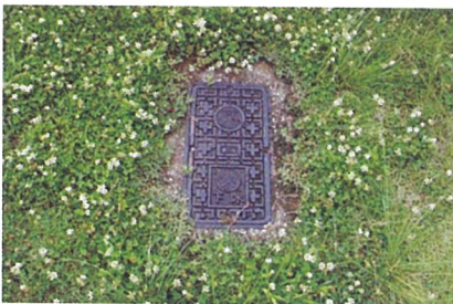
写真1 南港中央公園内の 芝生地に設置される マンホールトイレ
