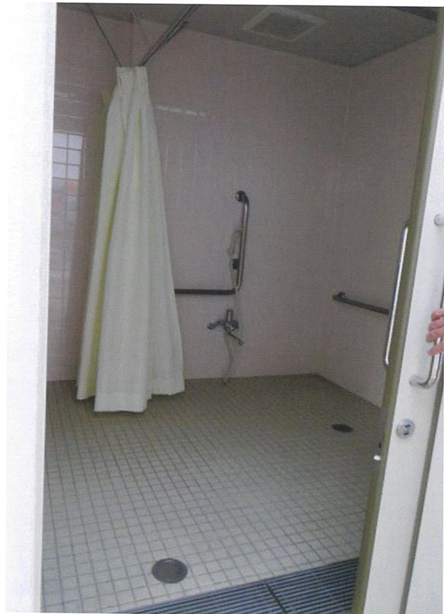
バリアフリー化されたシャワールームのある避難所
