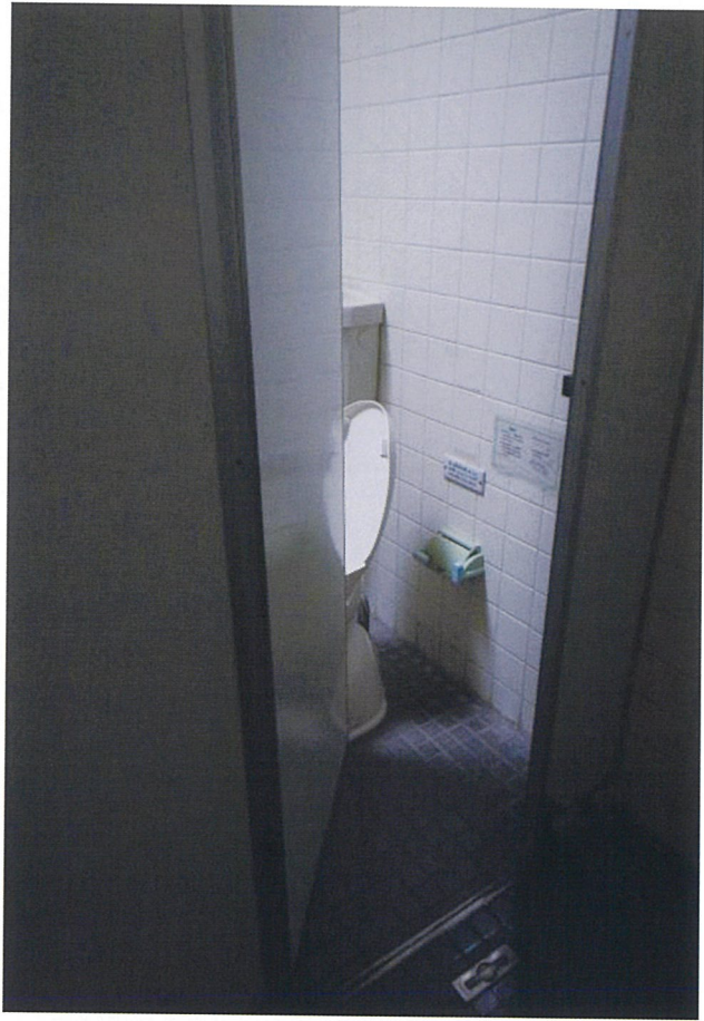
和式便器を洋式化したが生活用困難だった事例
