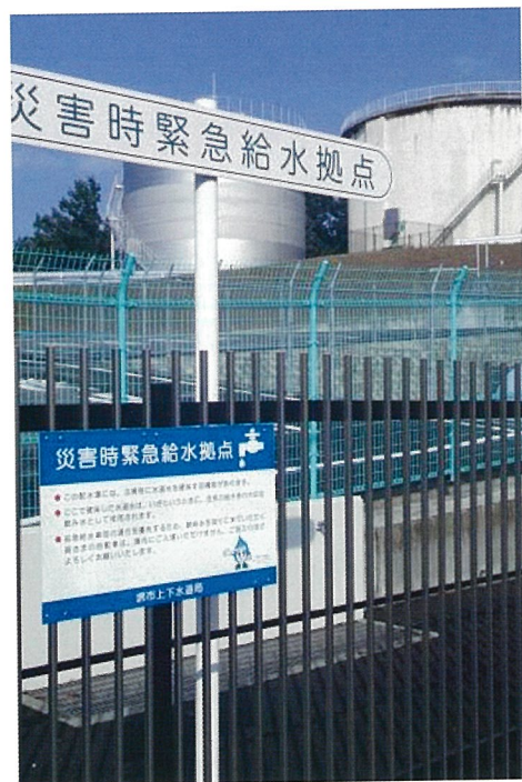
写真5 御池台配水池
