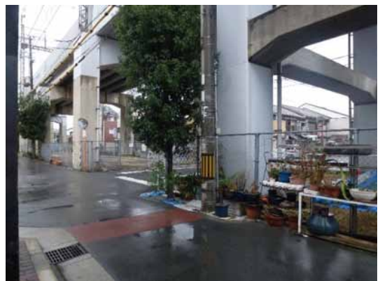
写真5 近鉄南大阪線の高架橋の様子
