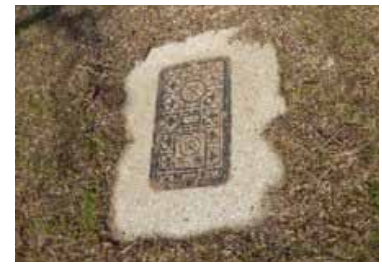
写真1 長居公園内自由広場南側に設置されるマンホールトイレ
