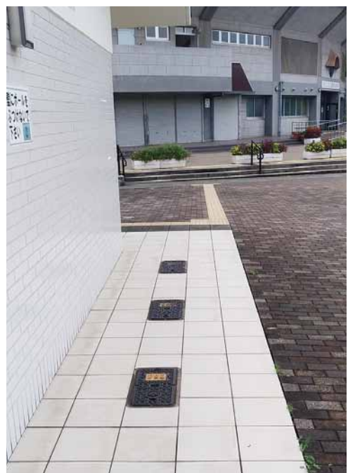
写真6 住之江公園内マンホールトイレ(図1、P8)
