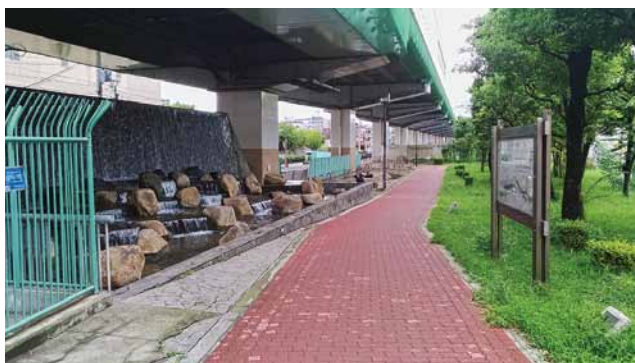
写真1 阪神高速堺線の高架下の十三間川跡(図1、P1)
