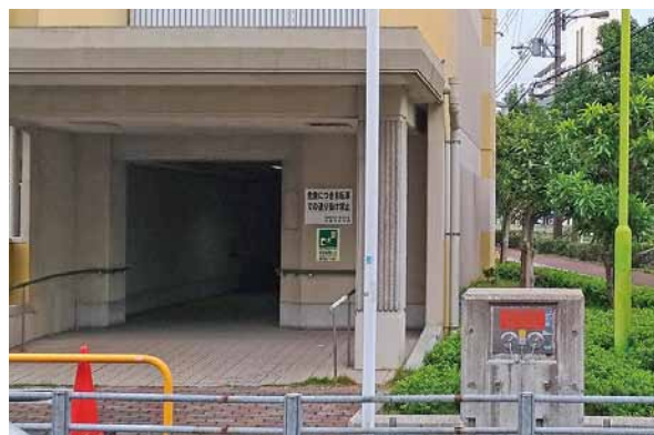
写真9 津波避難ビルの一例(出入口に緑のサイン、図1、P11)
