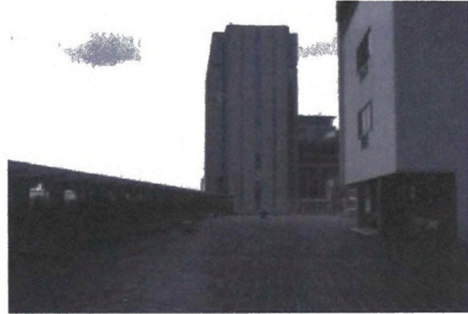
資料写真 3.3.3-4 新ダイビル 緑化の施されていないタイル床部分
