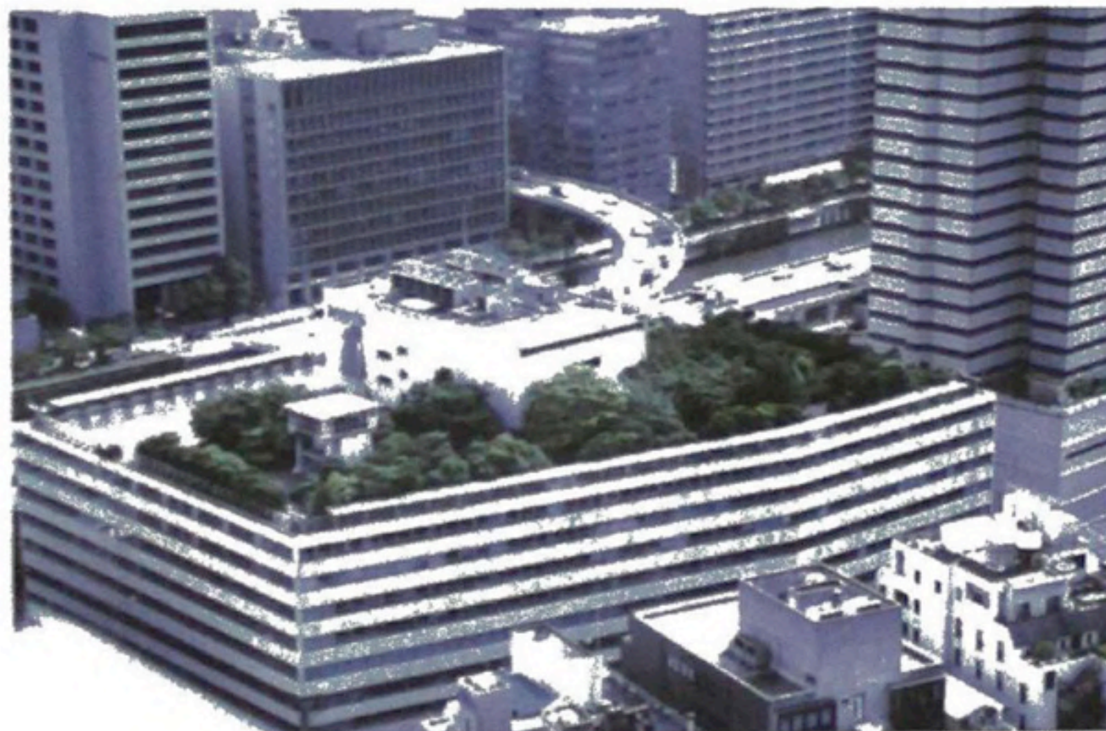
資料写真 3.3.3-2 オフィス街 屋上緑化を施した新ダイビル (大阪市北区堂島浜1)
