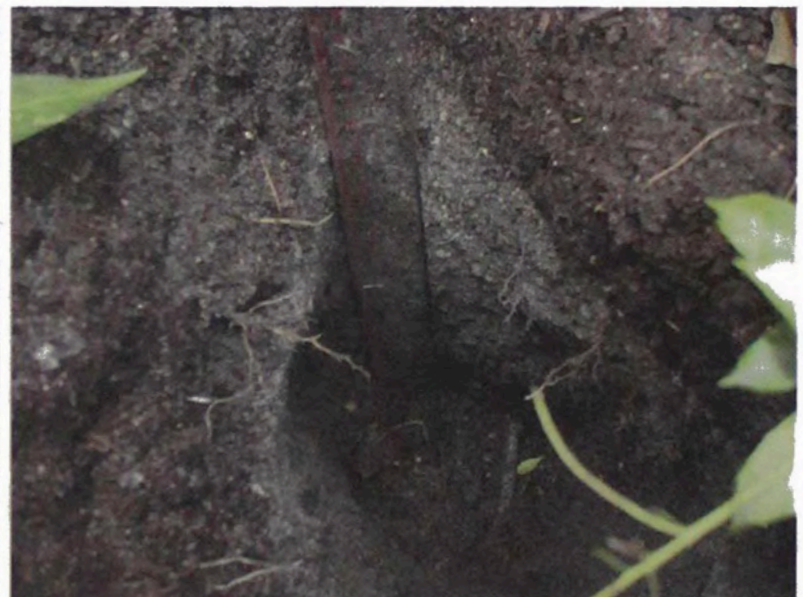
資料写真 4.2.2-7 本庁舎屋上緑化施設 北東角の土壌部分
