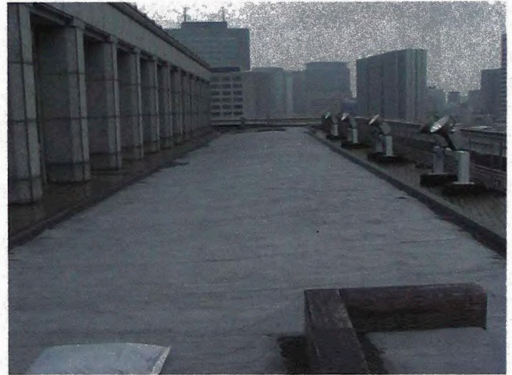
資料写真 4.2.2-2 本庁舎屋上緑化施設 施工中の北ゾーン(2003年6月)
