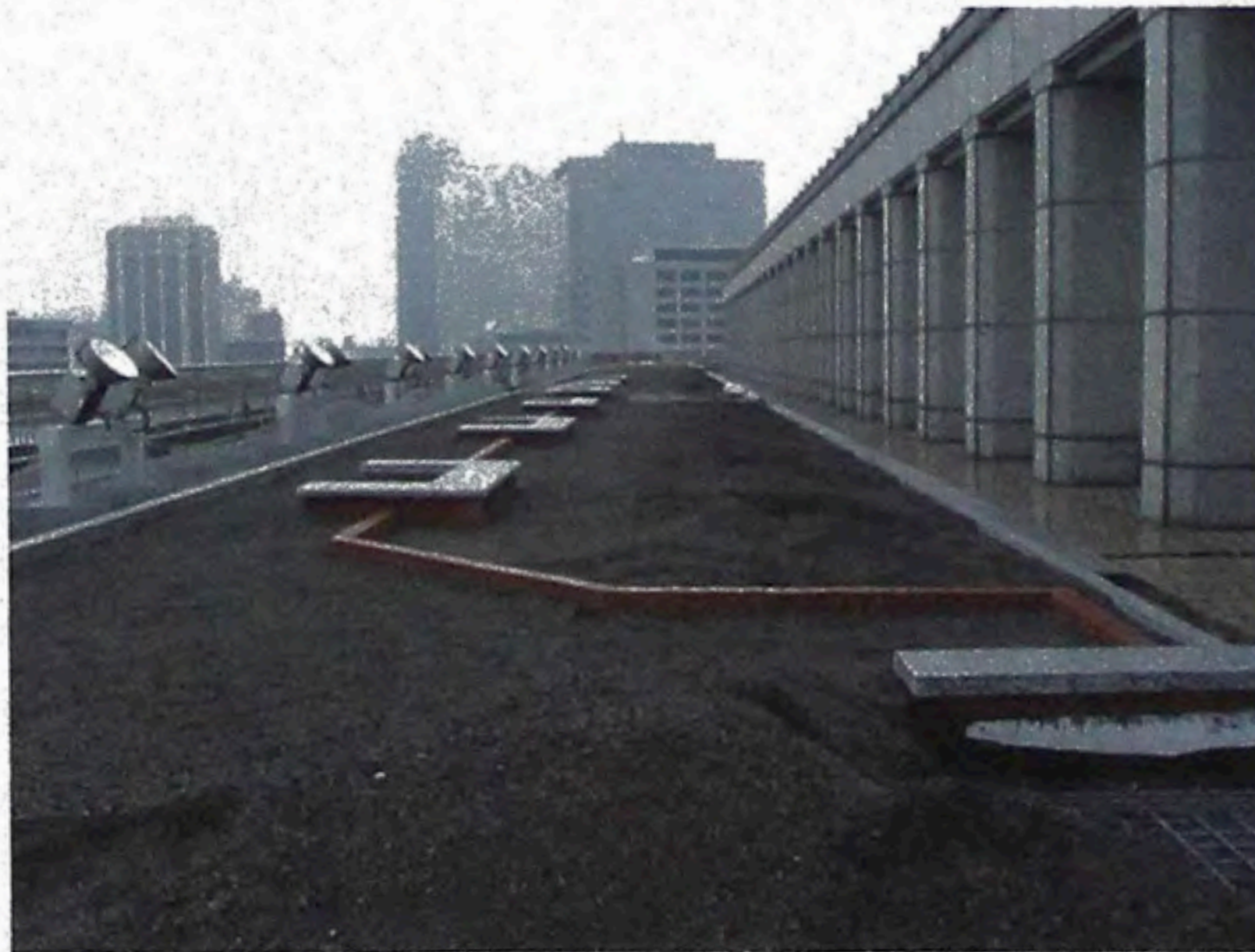
資料写真 4.2.2-1 本庁舎屋上緑化施設 施工中の南ゾーン(2003年6月)
