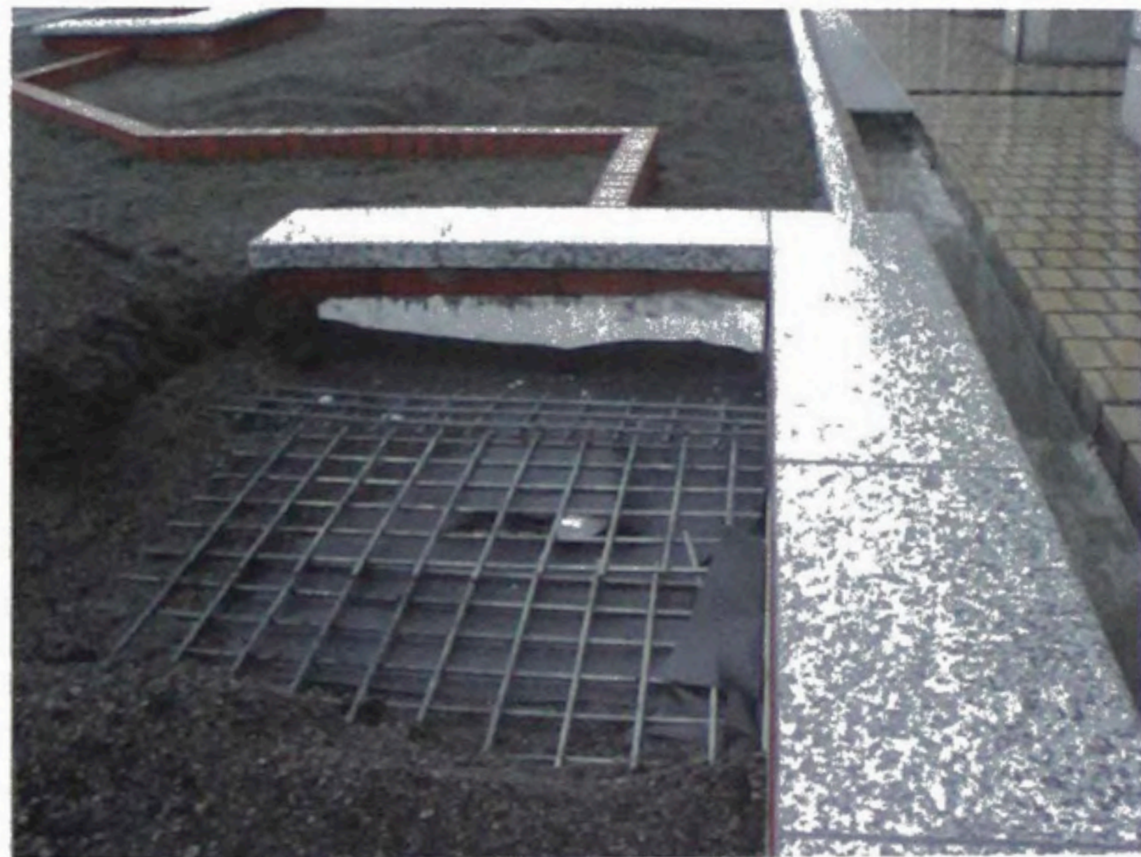
資料写真 4.2.2-4 本庁舎屋上緑化施設 施工中の土壌部分(2003年8月)
