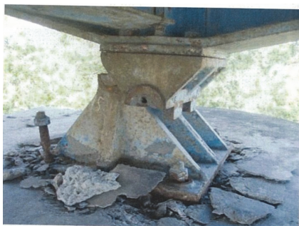
写真-4.1.1 支点移動の状況 1)
