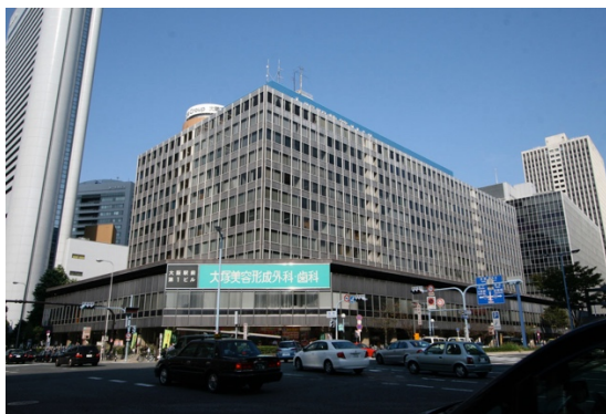
写真2-1 大阪駅前ビルの様子 (筆者撮影,2011)
