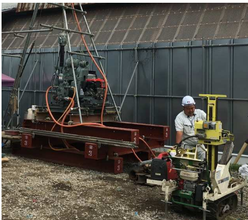
写真-4.1 試験状況例 (SPT と SWS 試験)
