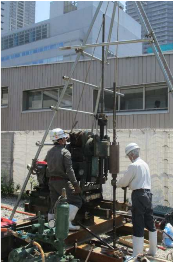
(1) ボーリング・SPT 実施の風景
