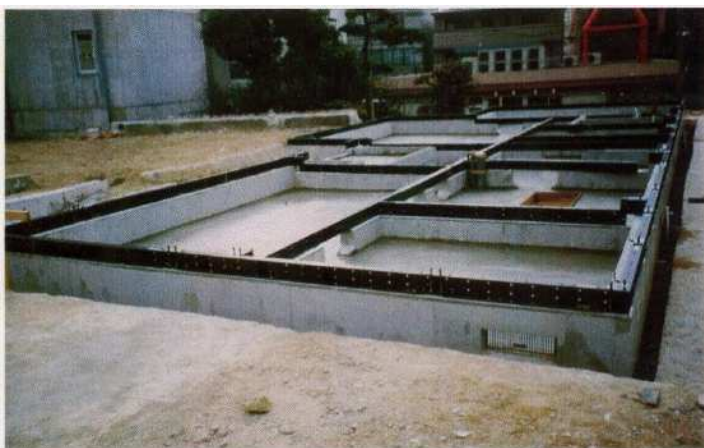
写真-1.5 住宅基礎と鋼製土台（諏訪市）
