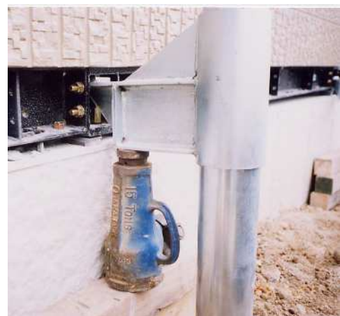
写真-1.6 鋼製土台活用によるジャッキアップ
