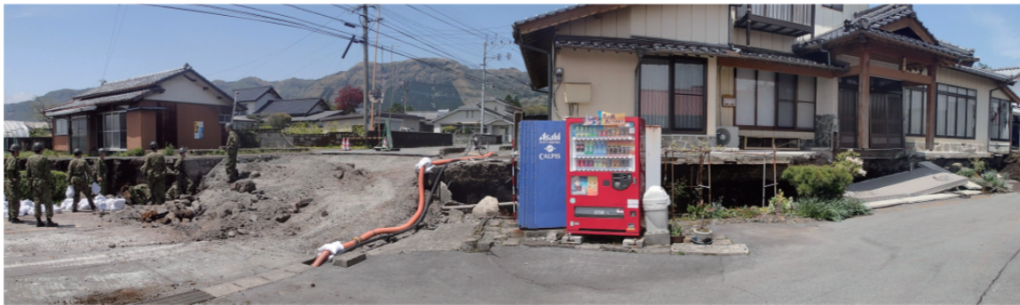
図4 阿蘇低地の阿蘇市広瀬南方の陥没帯北縁の段差と隣接の家屋の状況
