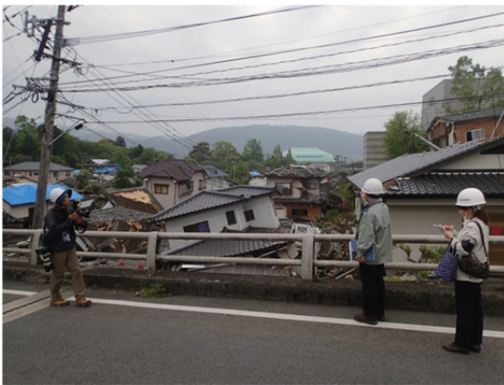
図12 益城町における段丘浸食谷斜面地の宅地盛土被害
