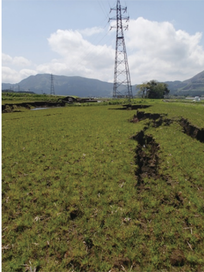
図7 阿蘇市宮山北方の陥没帯南縁の段差と傾いた送電塔
