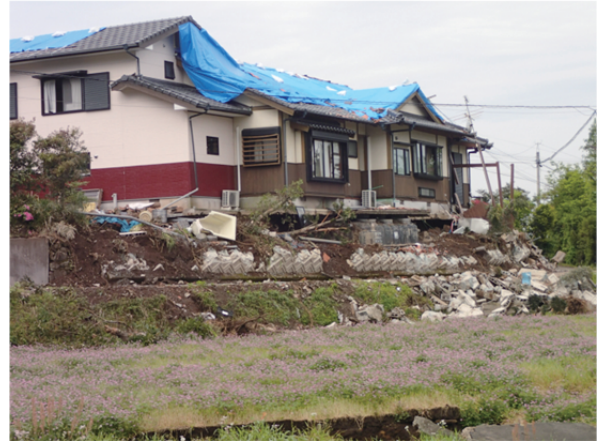
図11 西原村風当地区法肩の盛土崩落と家屋被害
