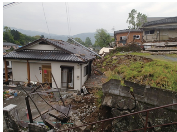
図12 益城町における段丘浸食谷斜面地の宅地盛土被害
