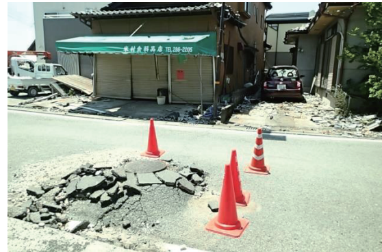
写真 26 益城町木山で見られたマンホールの隆起
