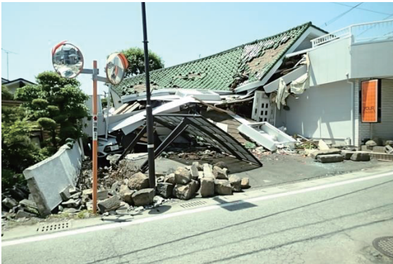
写真 23 益城町宮園地区の被害
