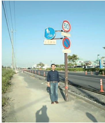
写真 29 熊本港内の標識の沈下
