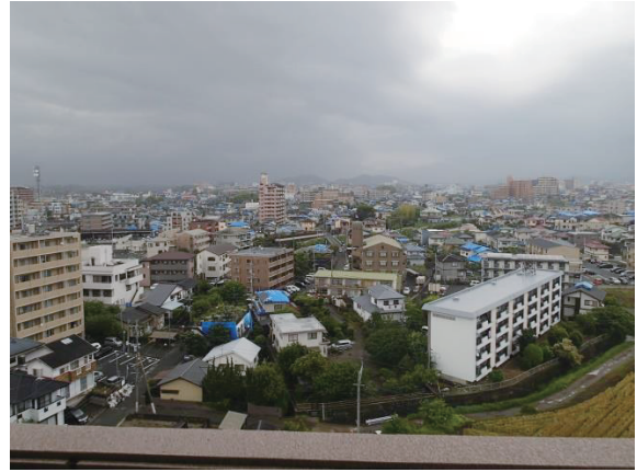
写真2 屋根部の被災状況を示すブルーシートの分布 （熊本市東区より東側を望む）
