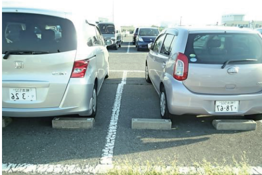
写真 31 熊本港内における水平変位
