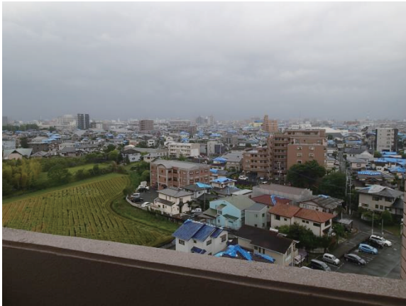
写真3 屋根部の被災状況を示すブルーシートの分布 （熊本市東区より南側を望む）
