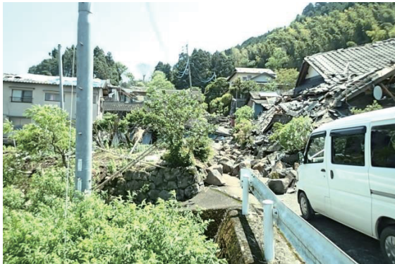
写真17 益城町県道28号線沿いの建物被害
