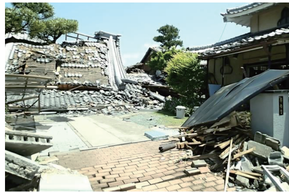
写真 24 益城町木山専寿寺の被害
