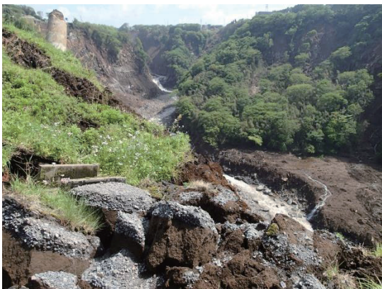
写真 15 南阿蘇村立野側より阿蘇大橋陥落部に続く大斜面崩壊を望む（北側）
