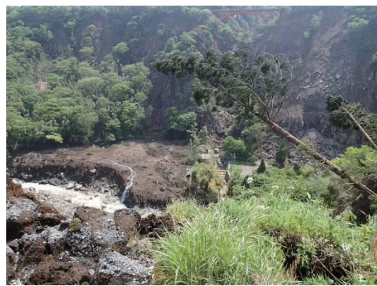
写真 16 南阿蘇村立野側より阿蘇大橋陥落部に続く大斜面崩壊を望む（東側）
