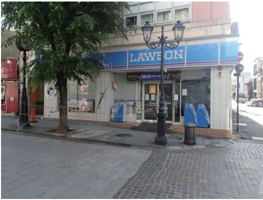
写真 11 熊本市中央区南坪井町コンビニエンスストアの被災
