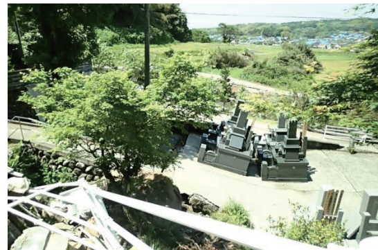
写真18 益城町日蓮宗日眞寺で確認された地盤のズレ
