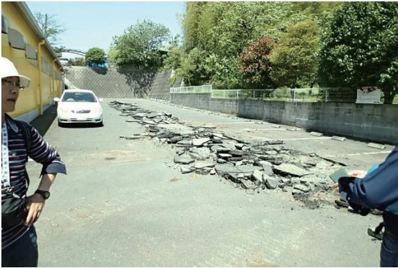
写真 21 益城町木山スーパー敷地内に生じた舗装の亀裂 （南北方向）
