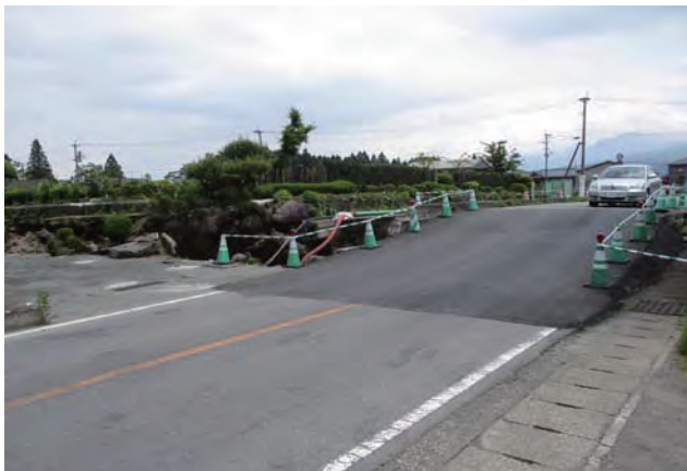
写真 30 阿蘇市狩尾の南側陥没変形（鉛直ずれ約 1.5m）
