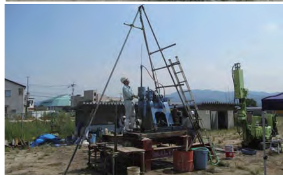
写真32 地盤調査の状況
