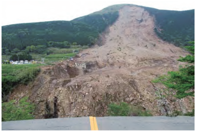
写真 15 阿蘇大橋付近の斜面崩壊
