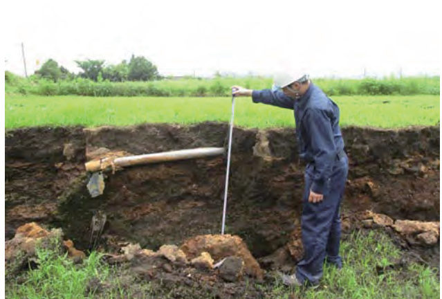
写真 31 阿蘇市狩尾の南側陥没変形（鉛直ずれ約 1.5m）
