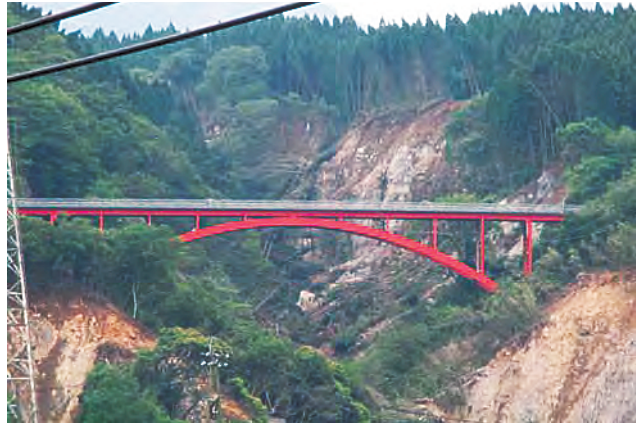
写真 13 斜面崩壊（南阿蘇橋付近）
