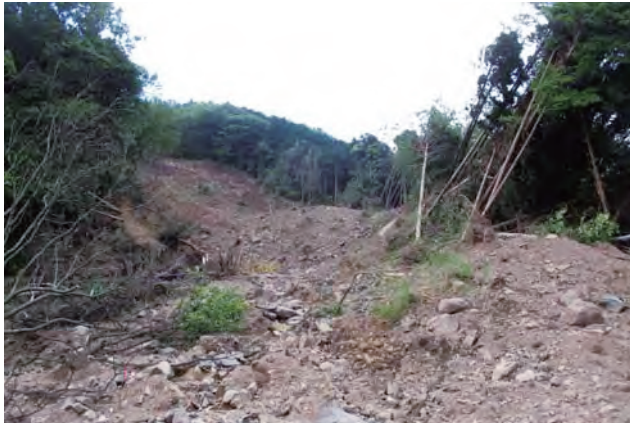
写真 12 斜面崩壊（大津町つつじ霊園）
