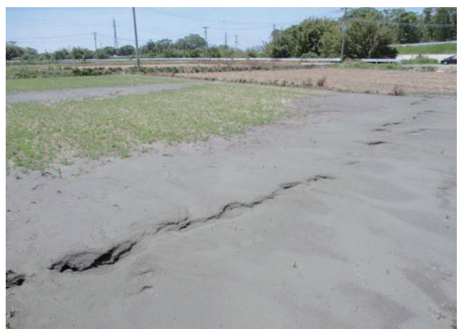
写真2 液状化による噴砂状況（熊本市南区元三町）
