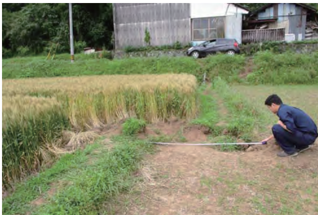
写真 22 益城町堂園の地表断層（水平ずれ約 2m）
