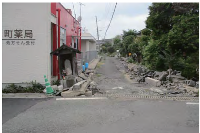
写真 25 益城町木山の地表断層（断層沿いの建物被害大）
