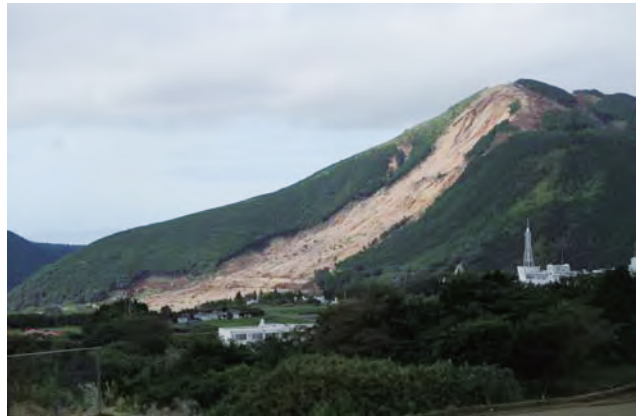
写真 17 阿蘇大橋付近の斜面崩壊（北側）
