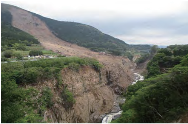
写真 16 阿蘇大橋付近の斜面崩壊（南側）
