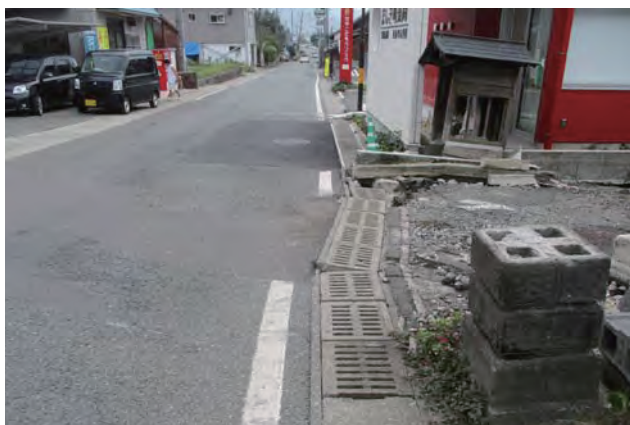
写真 24 益城町木山で新たに現れた地表断層
