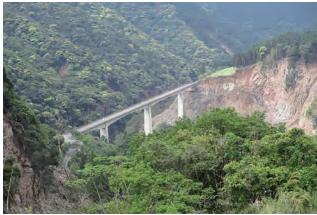
写真 14 斜面崩壊（阿蘇長陽大橋付近）
