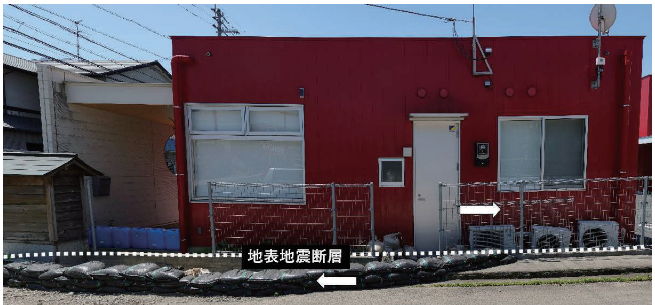
図 6 地表地震断層：断層はドアとフェンスの間を通過し，40cm 右横ずれさせた
