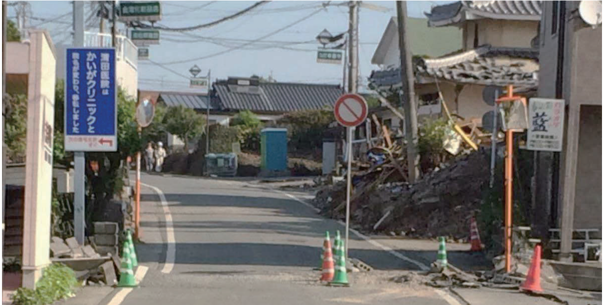
図 5 道路を 40cm 右横ずれさせた地表地震断層と周辺の家屋の被災状況（木山地区）
