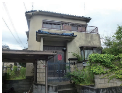
図8 ブルーシートでおおわれていない屋根瓦被害の例 図9 住宅の応急危険度判定で「危険」の赤色の張り紙が貼られている住宅の例 図10 線の左側が沈下した住宅の例
