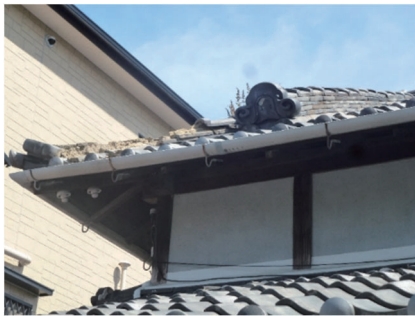
図8 ブルーシートでおおわれていない屋根瓦被害の例 図9 住宅の応急危険度判定で「危険」の赤色の張り紙が貼られている住宅の例 図10 線の左側が沈下した住宅の例
