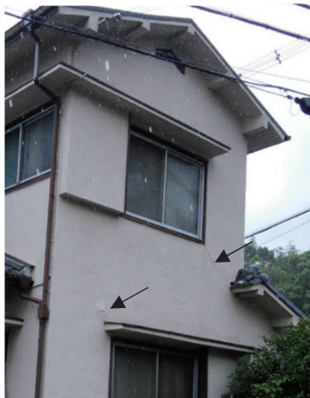
図11 窓枠から45度方向に入っている外壁の破損の例
