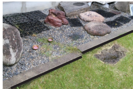
図8 ブルーシートでおおわれていない屋根瓦被害の例 図9 住宅の応急危険度判定で「危険」の赤色の張り紙が貼られている住宅の例 図10 線の左側が沈下した住宅の例
