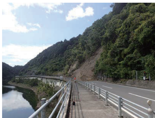
写真-7 県道29号線における山崩れ
