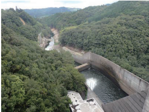
(a) 通路北側より下流を望む
