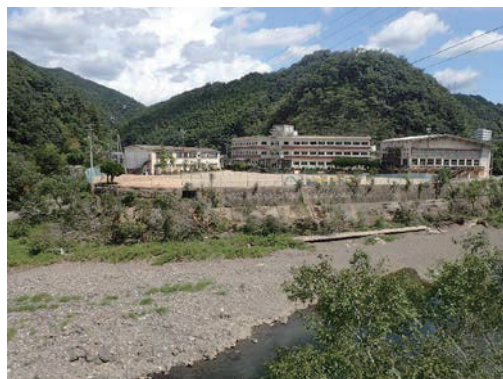
写真-6 大洲市立肱川中学校の敷地内への浸水痕跡
