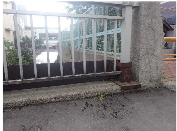
写真-17 既存の橋に取り付けられた遮水板
