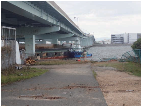
写真-10 県道 573 号線に衝突した台船
