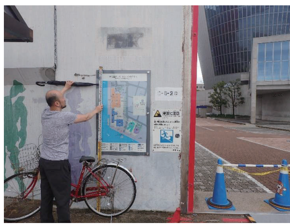
写真-2 天保山西岸壁防潮壁に残る痕跡
