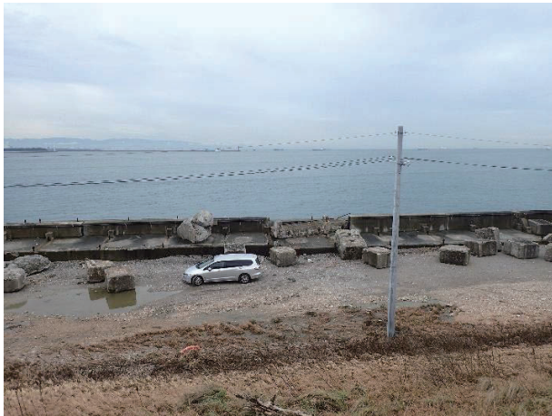
写真-4 夢洲南側岸壁
