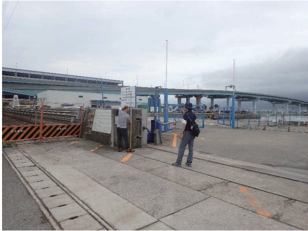
写真-8 鳴尾浜北西側防潮堤
