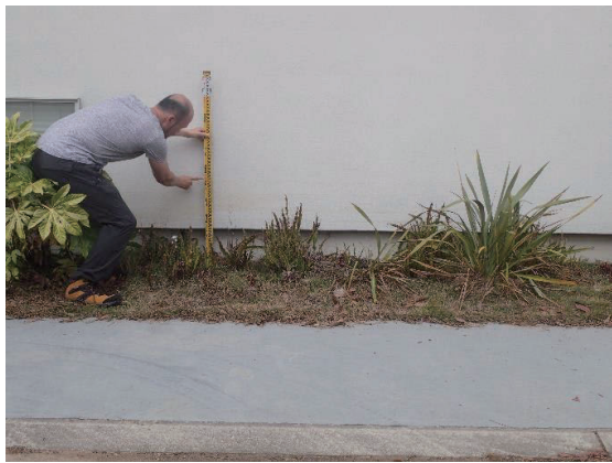
写真-14 芦屋市涼風町の浸水痕跡
