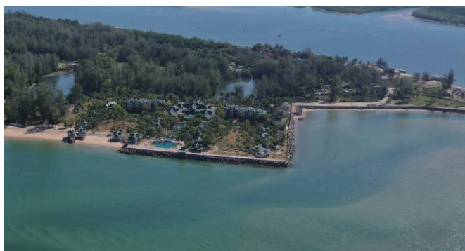
図 9 海岸浸食が進む護岸
