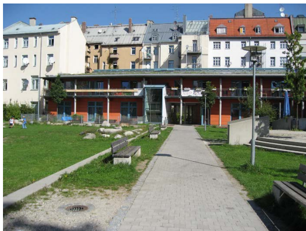
図 26 : ヴェストエントの景観 10 プレハブ風 2 階建ての建物の住所はランツベルガー通り 45a となっているが、実質的にはカトリック聖ベネディクト教会の隣のオープンスペースにある。ここには Dona Mobil や民族ダンスなどの移民文化団体や市立託児所が入居している。ランツベルガー通りは、背後の 4～5 階建て集合住宅の向こう側にあるヴェストエントの最北部でこの地区を東西に貫く大きな通りである。2008 年 9 月 6 日報告者撮影
