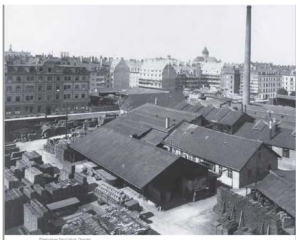
図 11 ヴェストエントに立地していた樽製造工場（ドレクスラー（Drexler）社）ほかに、ビール醸造所、タイヤ工場、ミシン製造工場などがあった。ビール醸造所を除いてヴェストエントから移転ないし閉鎖して今はない。
