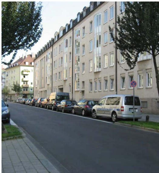
図 33 : ヴェストエントの景観 17 トウルベック通り側からみた協同組合集合住宅 2008年9月6日報告者撮影
