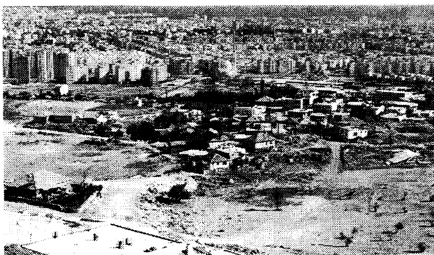
写真7 撤去中のスクォッター地区（マサダア南西斜面）
