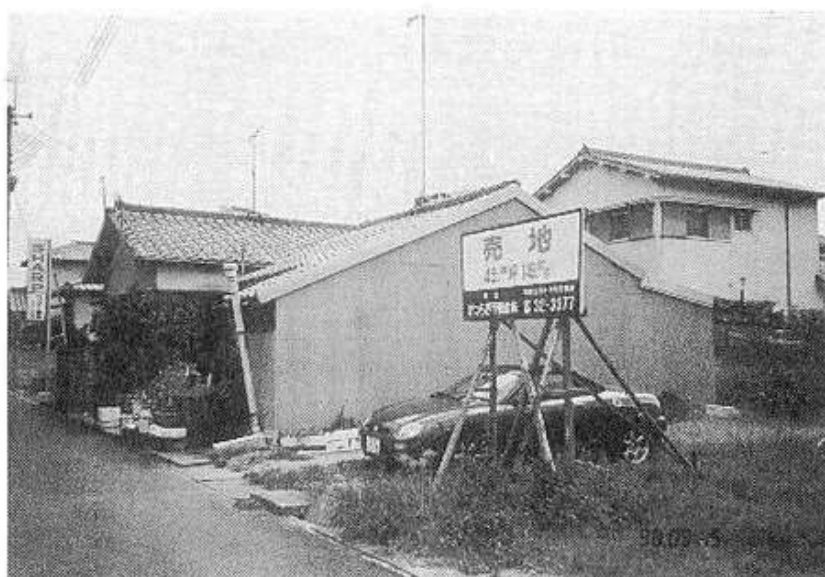
写真3 福島地区、22坪・平屋4軒長屋住宅 (1998年9月撮影)
