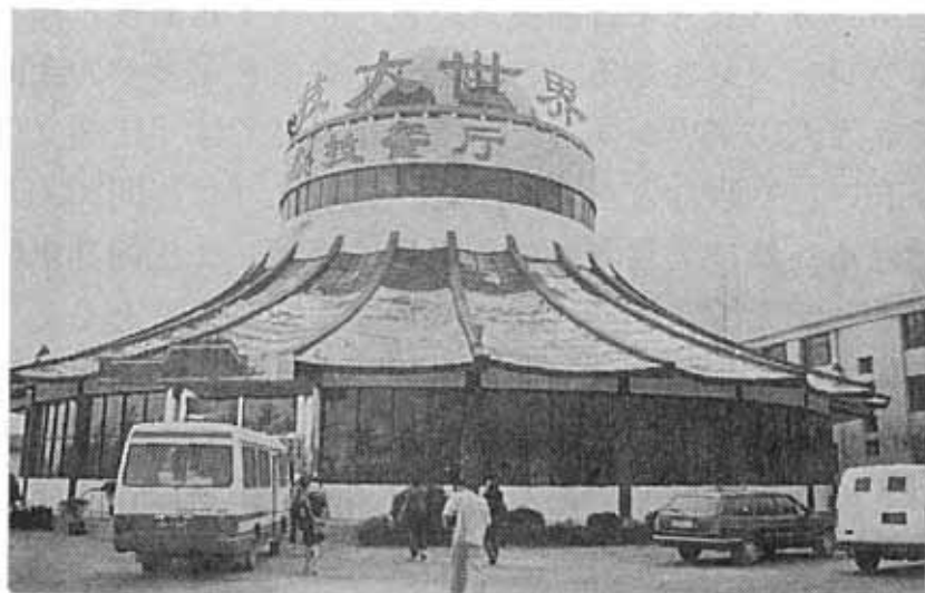
図14 雑技賓館（レストラン棟）
