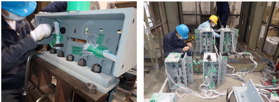
(b) 支持部材と床版を仮組後締め付けの実施
