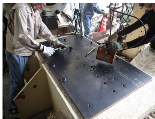
(b) ベースプレートの設置
