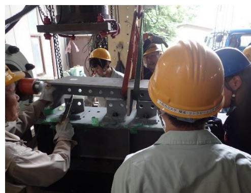
(d) 鋳鉄床版モジュールの仮組み
