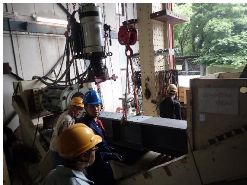
(c) H 鋼の設置
