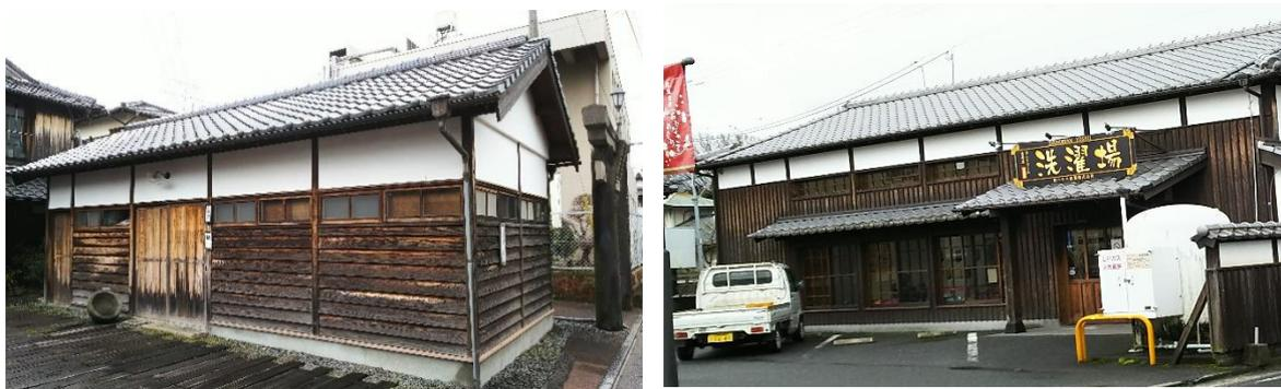
図4.9 真壁造による新築修景建造物（著者撮影）
