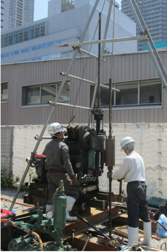
(1) ボーリング・SPT 実施の風景
