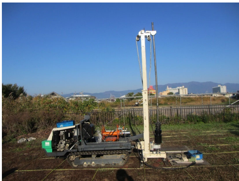
写真-2.4 H-DCPT の手動式試験機の例 (JDF 社製)
