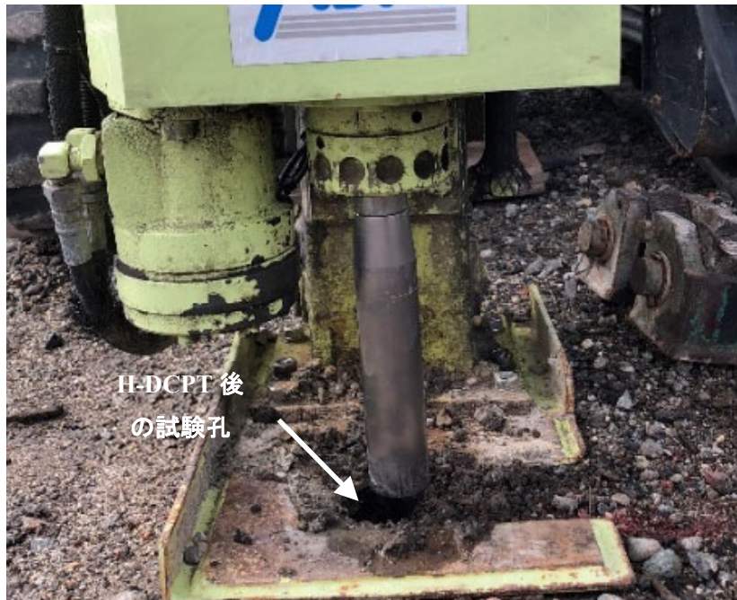
写真-3.2 傾斜角測定コーンの試験孔への設置状況
