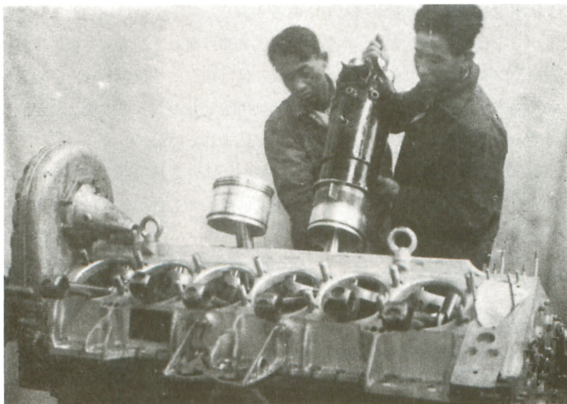
図 8-9 三菱ユンカース「ユ式一型」800 馬力発動機における気筒取付作業
